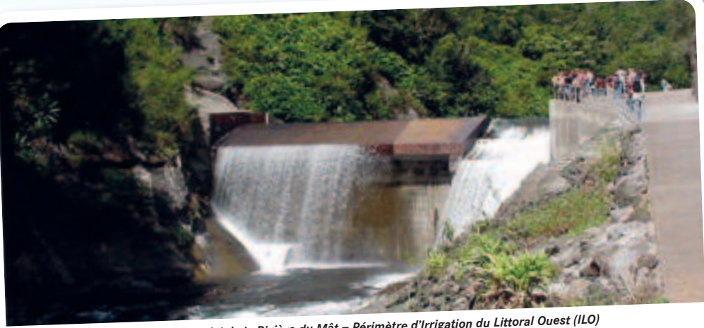
Captage superficiel de la Rivière du Mât – Périmètre d'Irrigation du Littoral Ouest (ILO)
