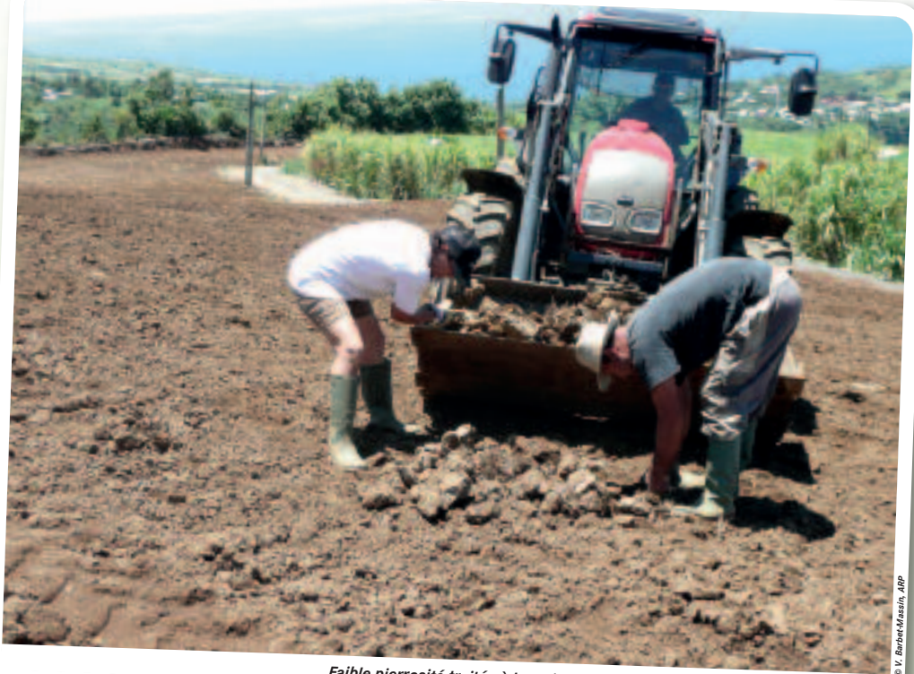
Faible pierrosité traitée à la main
