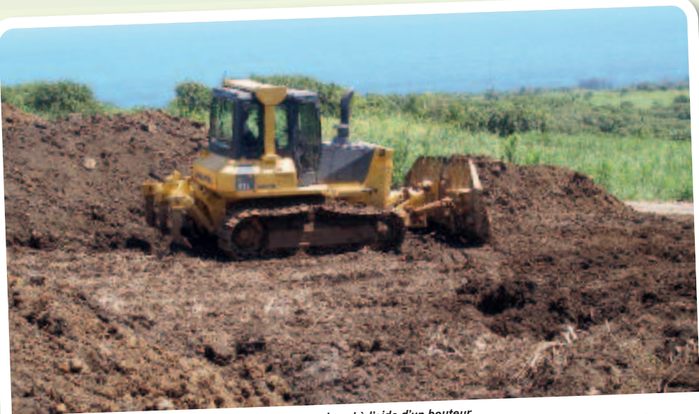
Remaniement du sol à l'aide d'un boteur
