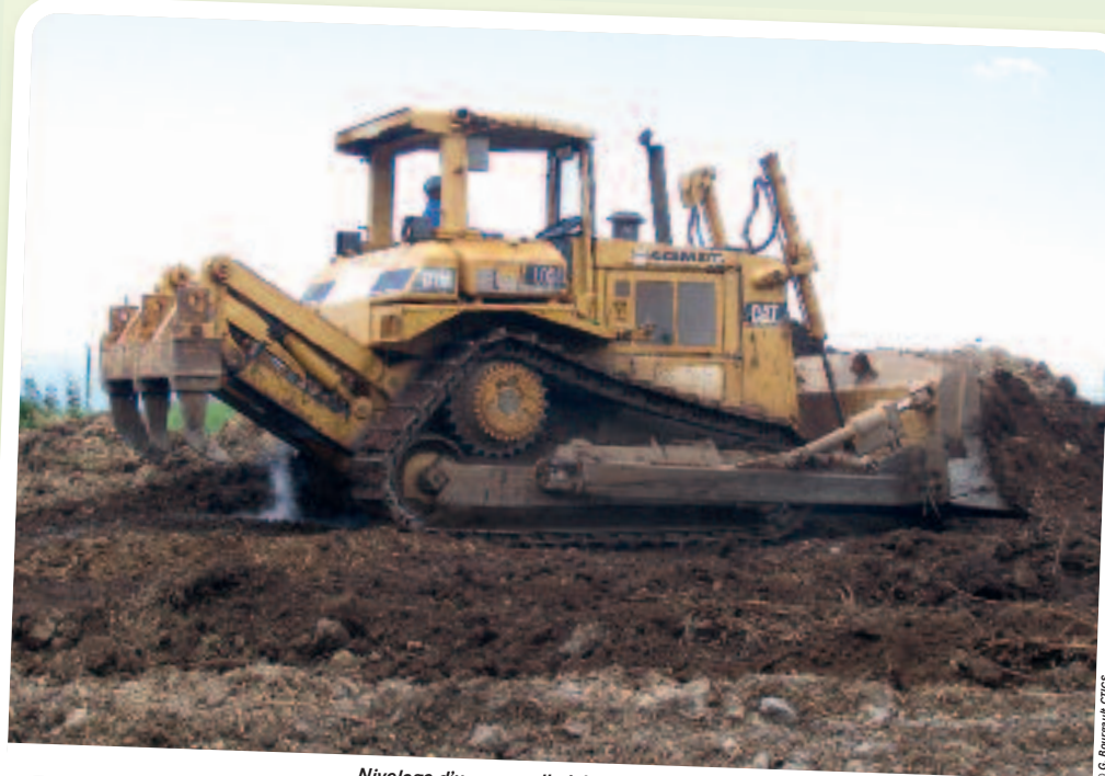
Nivelage d'une parcelle à l'aide d'un bouteur
