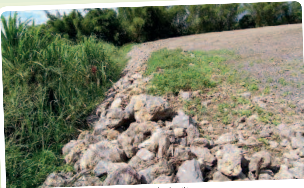
Remblais en bas de pente
