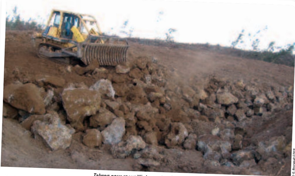
Talweg pour recueillir les restes d'épierrages
