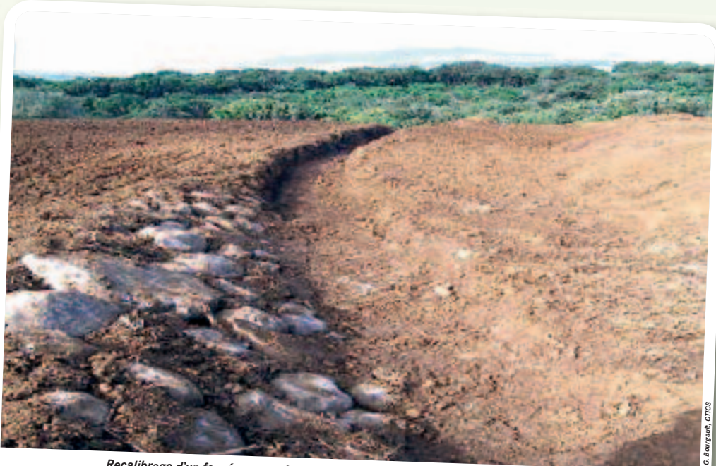
Recalibrage d'un fossé avec renforcement des berges dans les zones les plus exposées
